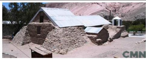
**OBSERVACIONES** Más que agrietamientos se presentaba disgregación del adobe y mampostería de piedra por falta de aplanado, y alteraciones en las torres y en el sistema de cubierta
