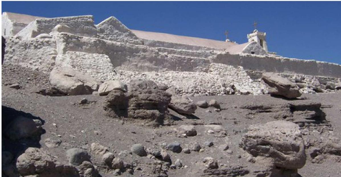
**Figura 45.** Deslave de ladera oriente del río Loa y erosión en la base del muro del atrio de la iglesia de Chiu Chiu, producto de crecidas del cauce del río Loa. Fuente: Google Earth.
